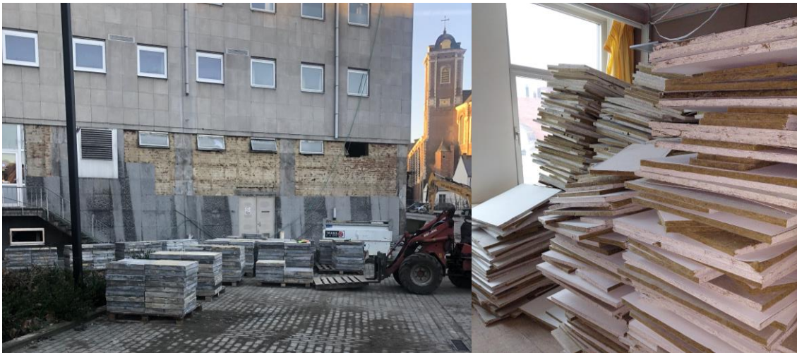
Foto's van case Zwartzustervest (arduinen gevelementen en rotswolpanelen) © Stad Mechelen
